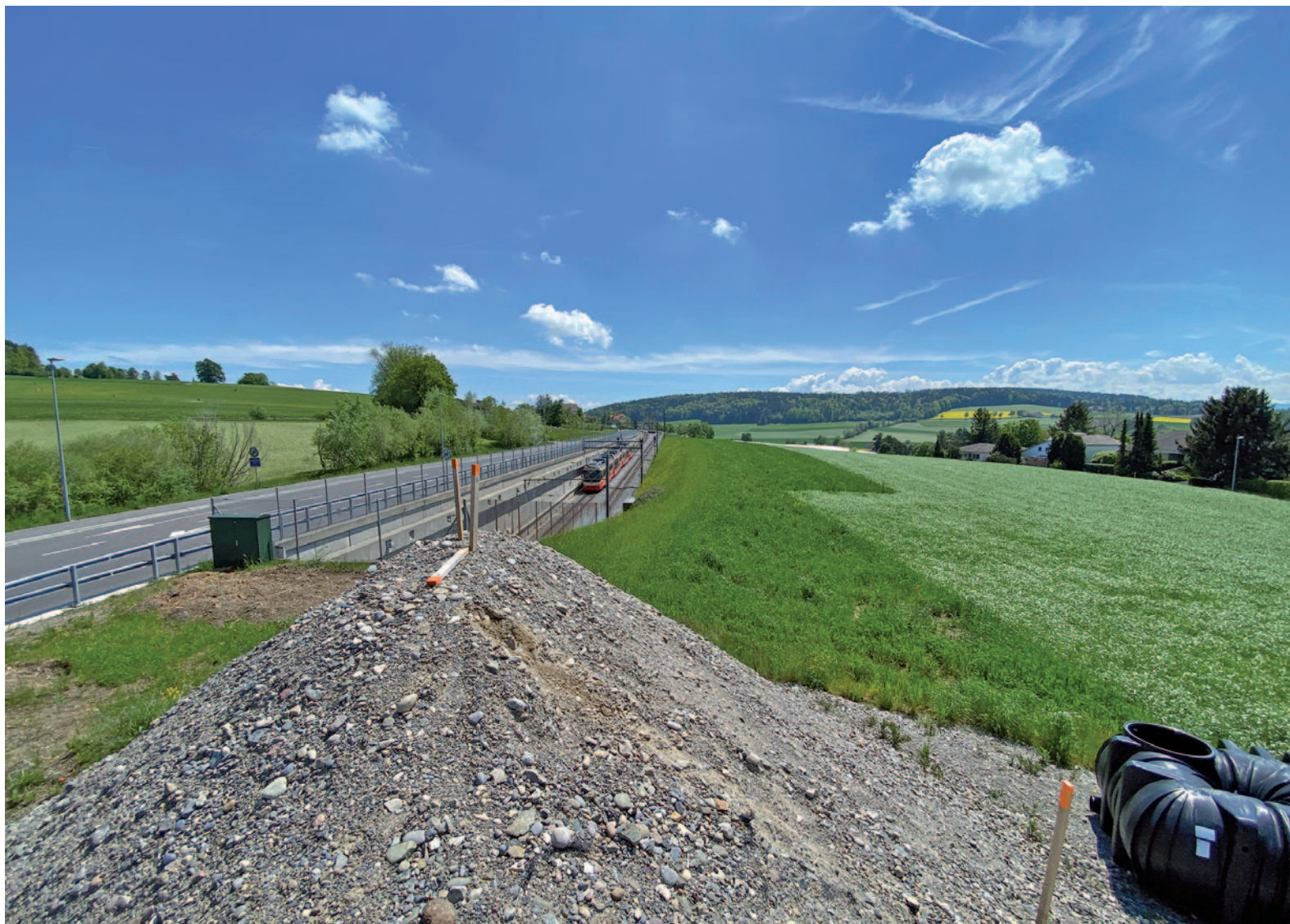
Südlich der Haltestelle Neue Forch wird ab Ende Mai 2022 der Installationsplatz für die Bauarbeiten für die Sanierung des Tunnels Zumikon eingerichtet.
