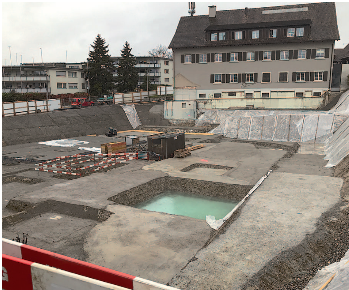
Das sich im Bau befindende neue Feuerwehrgebäude, zusammen mit dem Heimfall der KEK und dessen Umbau, sind die Hauptinvestitionen des laufenden und der kommenden Jahre der Gemeinde.
