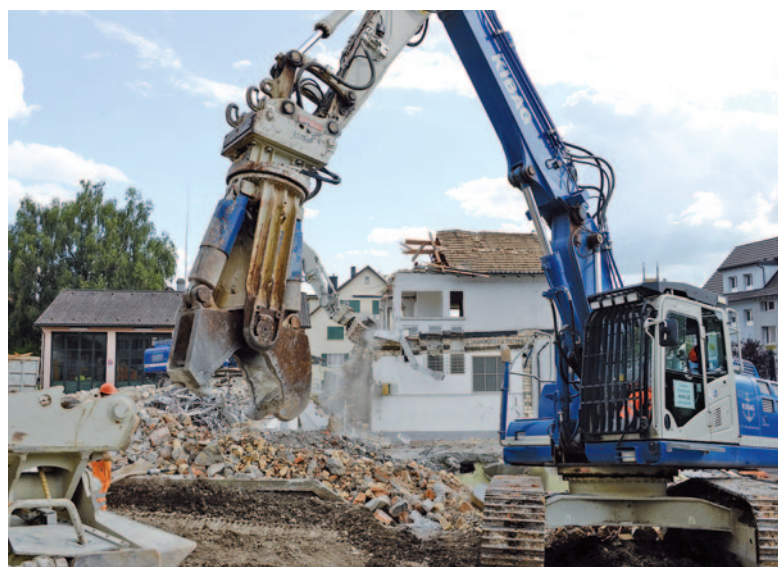
84 Jahre im Dienst: Das alte Feuerwehrgebäude hat ausgesorgt. Foto: Martin Bachmann
