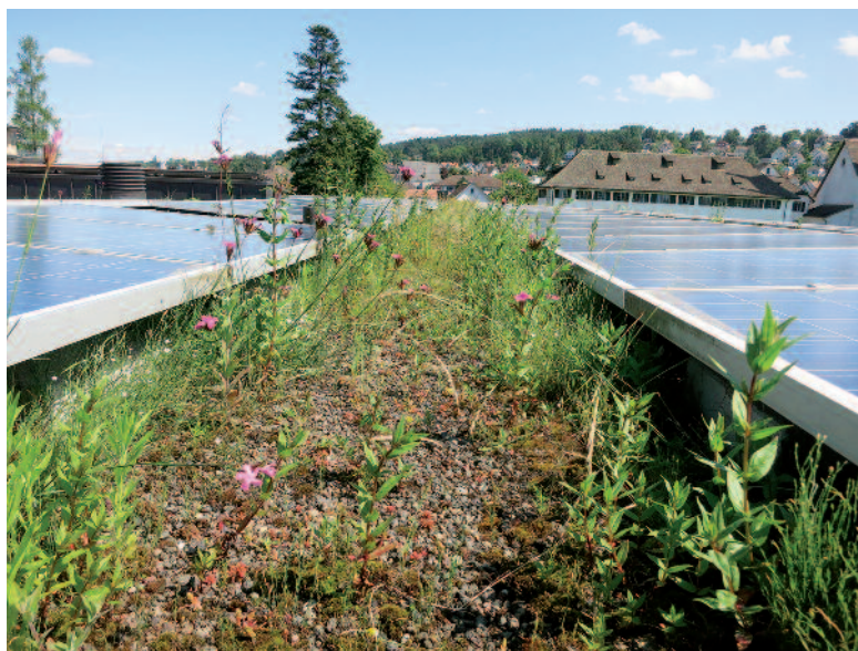
Natur auf dem Flachdach der Kantonsschule Küsnacht.
