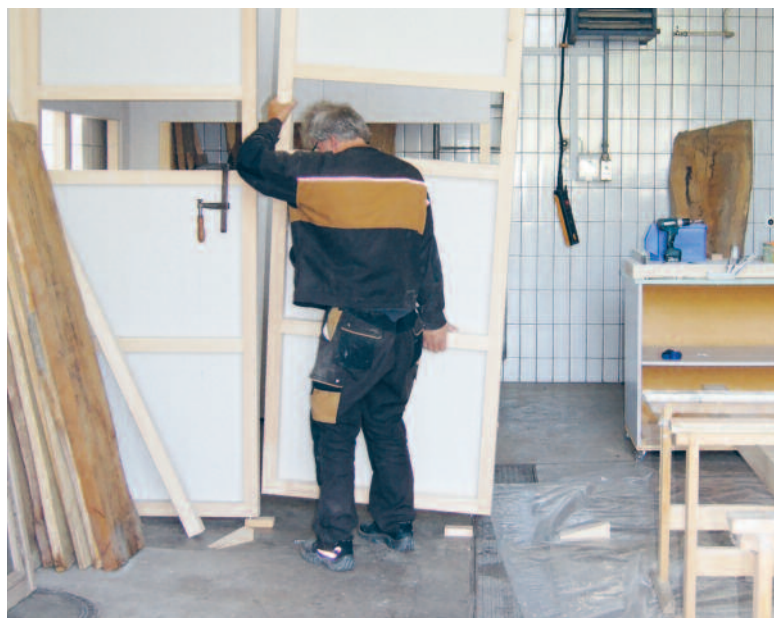
Ein neuer Arbeitsbereich wird ausgebaut: Die meiste Arbeit machen die Klienten und die Freihof-Mitarbeitenden selber.
