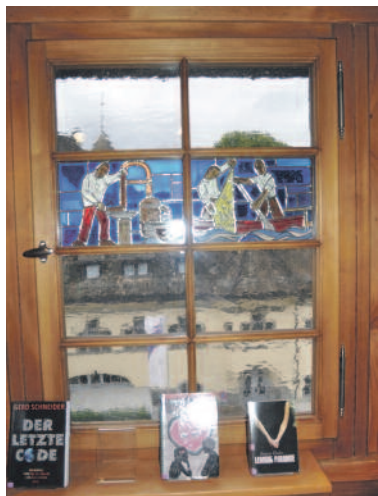
Historische Fenster bewahrt, aber innen dig schalldämmend. (Ruth Weber)
