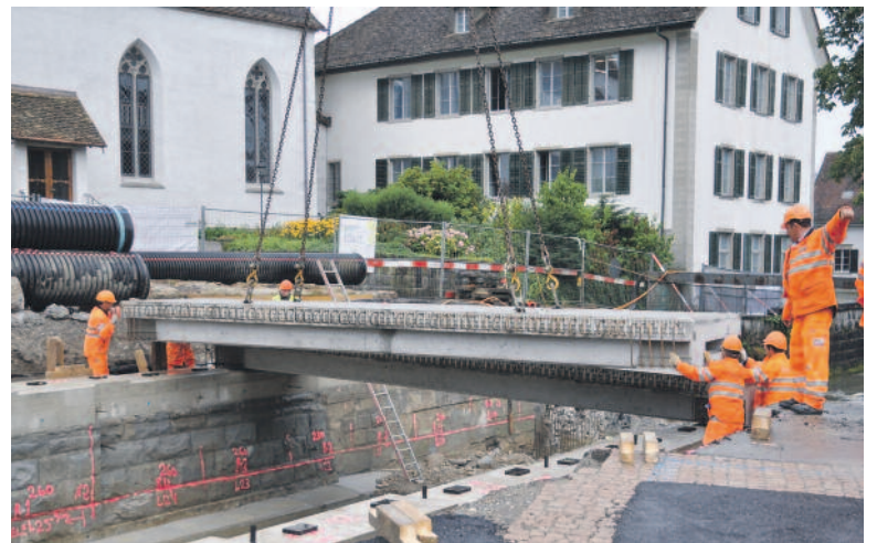
Aus elf Elementen entsteht die Brücke.
