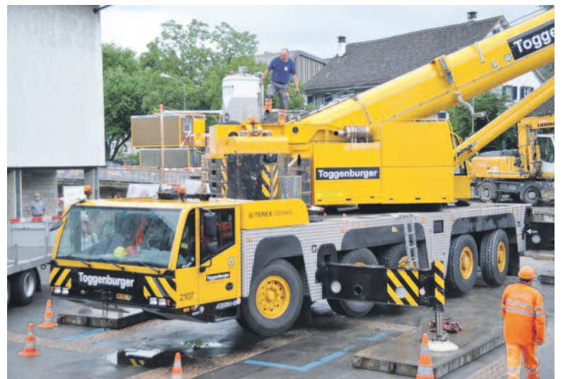
Ein 60 Tonnen schwerer Kran hievt die Brückenelemente zum Bach hin. (Ruth Weber)
