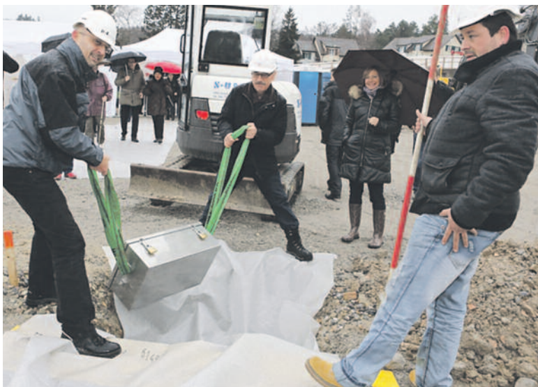
Die Grundstein-Box der neuen Tägerhalde wird versenkt. Von links: Sandro Polo, Generalunternehmung P-4 AG, und Martin Bachmann, Gemeinderat, im Hintergrund Ursula Gross Leemann, Gemeinderätin und Mitglied der Baukommission Tägerhalde.
