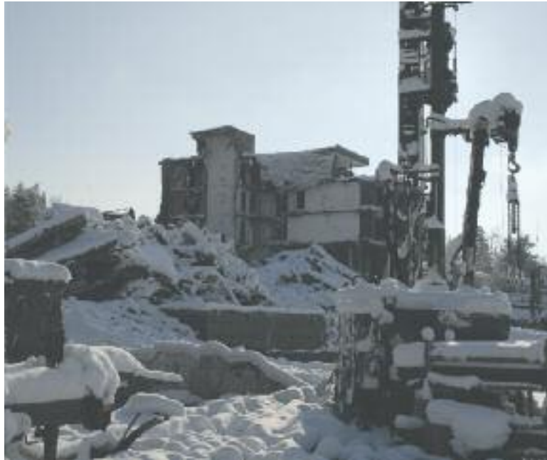
Die Abbrucharbeiten in der Tägerhalde sind in vollem Gange.
