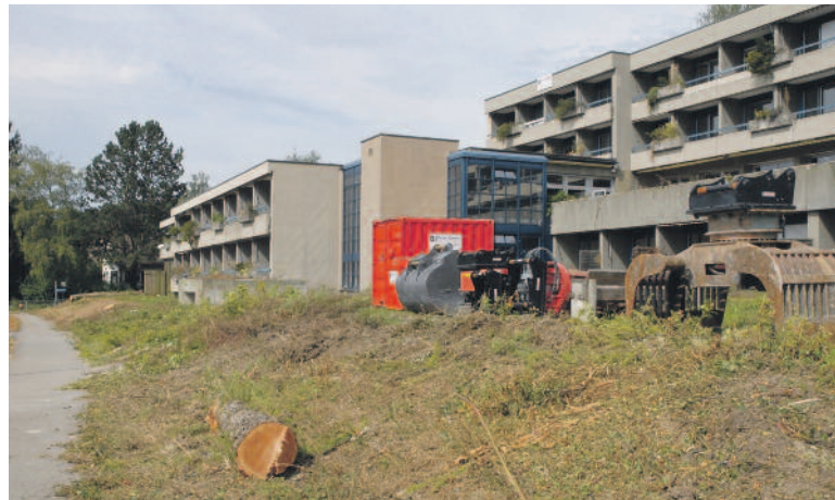
Die Rückbauarbeiten sind im Gange.
