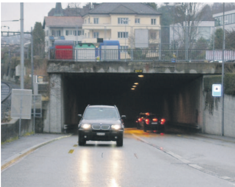
Heutige Unterführung an der Oberwachtstrasse.
