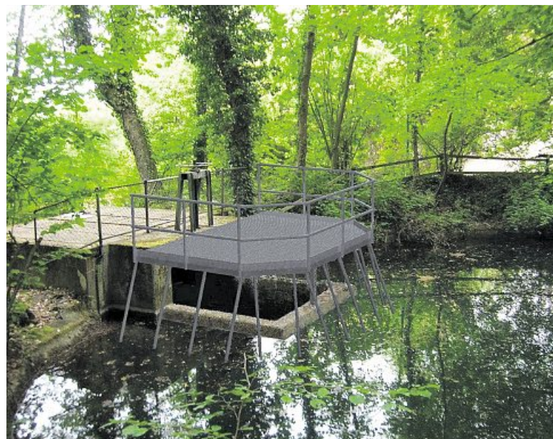
Fotomontage des Ablaufbauwerks mit dem neuen Vorbau zur Vergrösserung der Abflusskapazitäten. (zvg)
