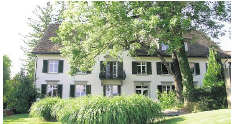
Das 1770 erbaute Zürichseehaus Fennergut wird als Kinder- und Jugendheim mit Kinderkrippe genutzt.
