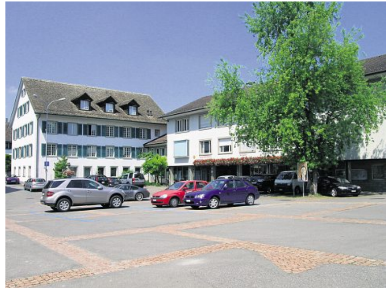
Der Belag des Dorfplatzes muss saniert werden. (Ruth Weber)
